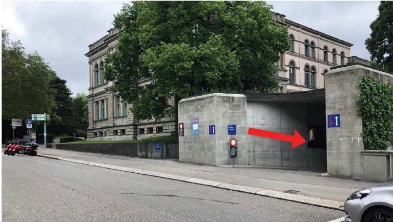
Einfahrt Garage Karl-Schmid-Strasse 4
